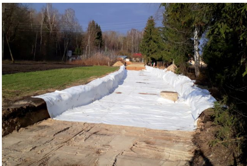
Patlaban notiek ceļa pamatnes sagatavošana un ģeotekstila ieklāšana.
