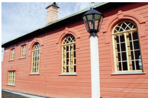
Foto: Restaurētā sinagogas ēka
