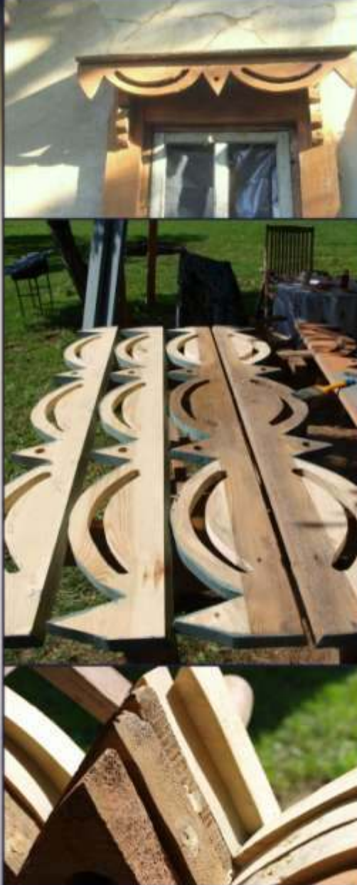
LOGA DETALĀS RESTAURĀCIJAS PROCESĀ
