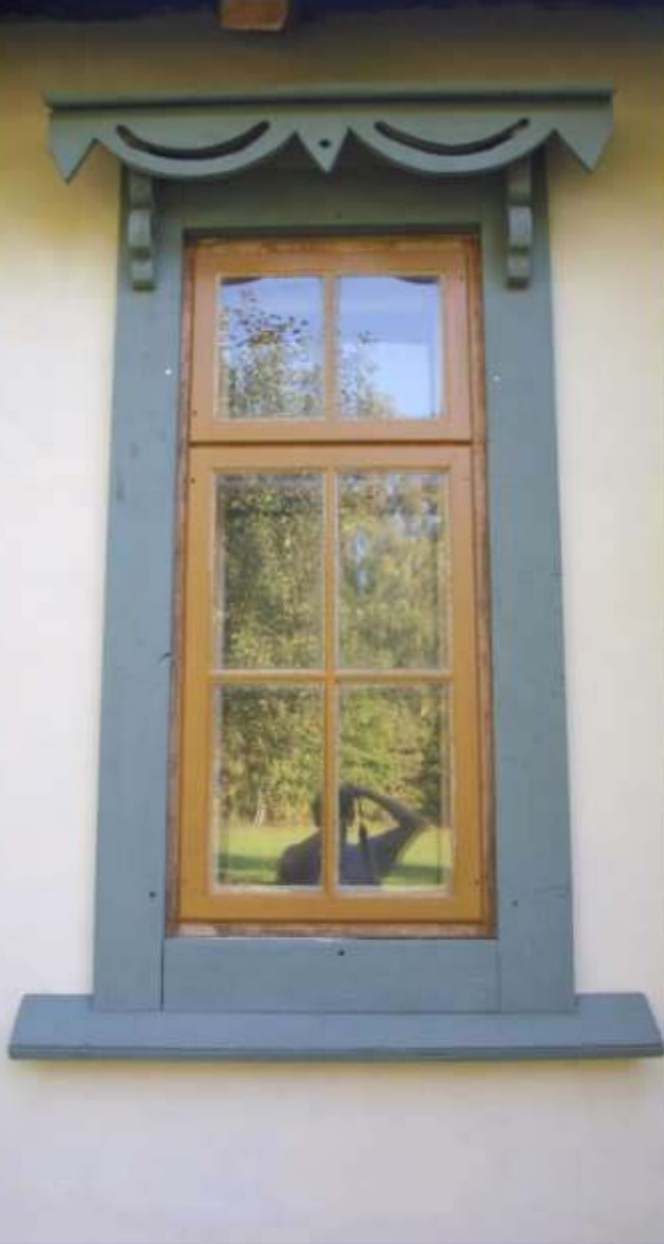
LOGS UZ APMESTAS FASĀDES PĒC ATJAUNOŠANAS JAUNA AUTENTISKA VĒRTNE, RESTAURĒTA APMALĒ, KRĀSOTS AR LINEĻĻAS UN MILTU KRĀSĀM
